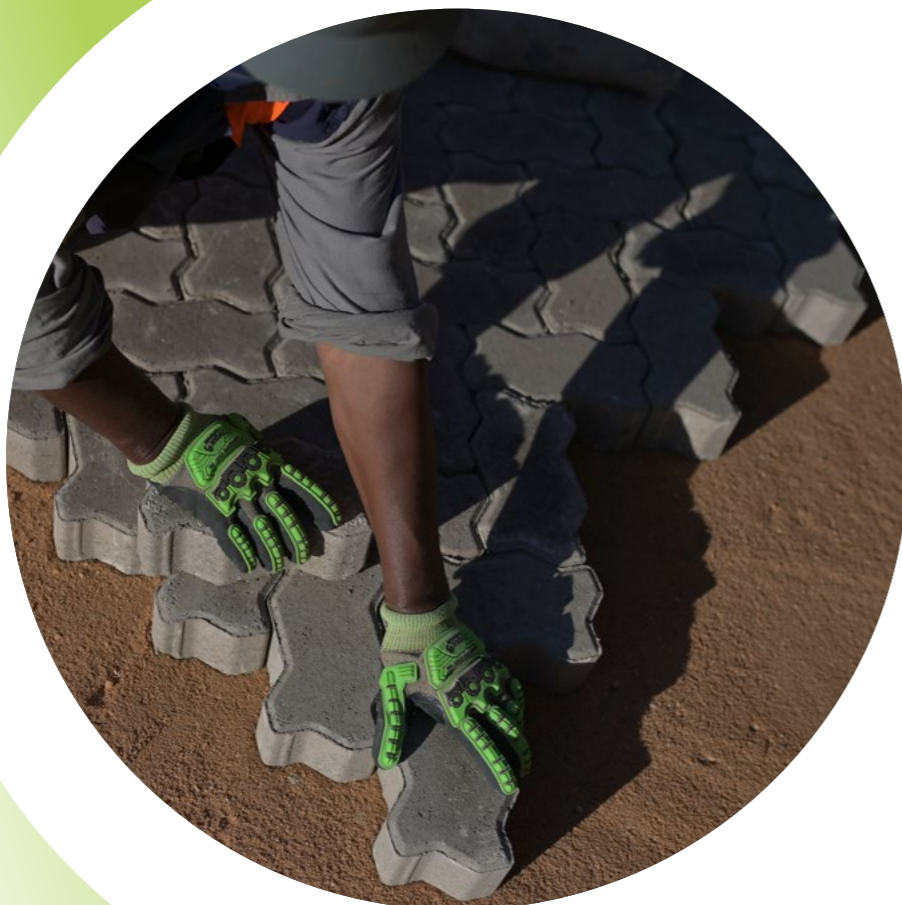
Calçamento com blocos produzidos a partir de rejeito da Samarco
