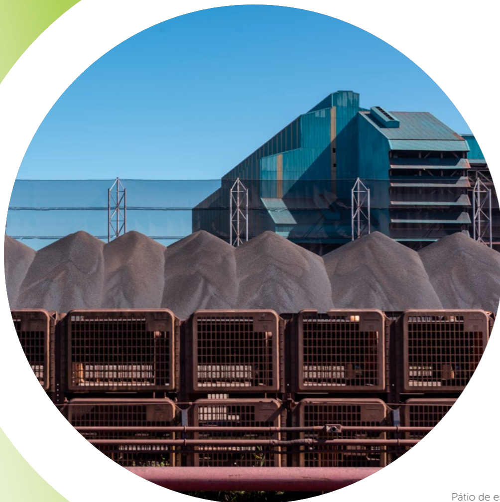
Pátio de estocagem e usinas, Complexo Ubu (ES)
