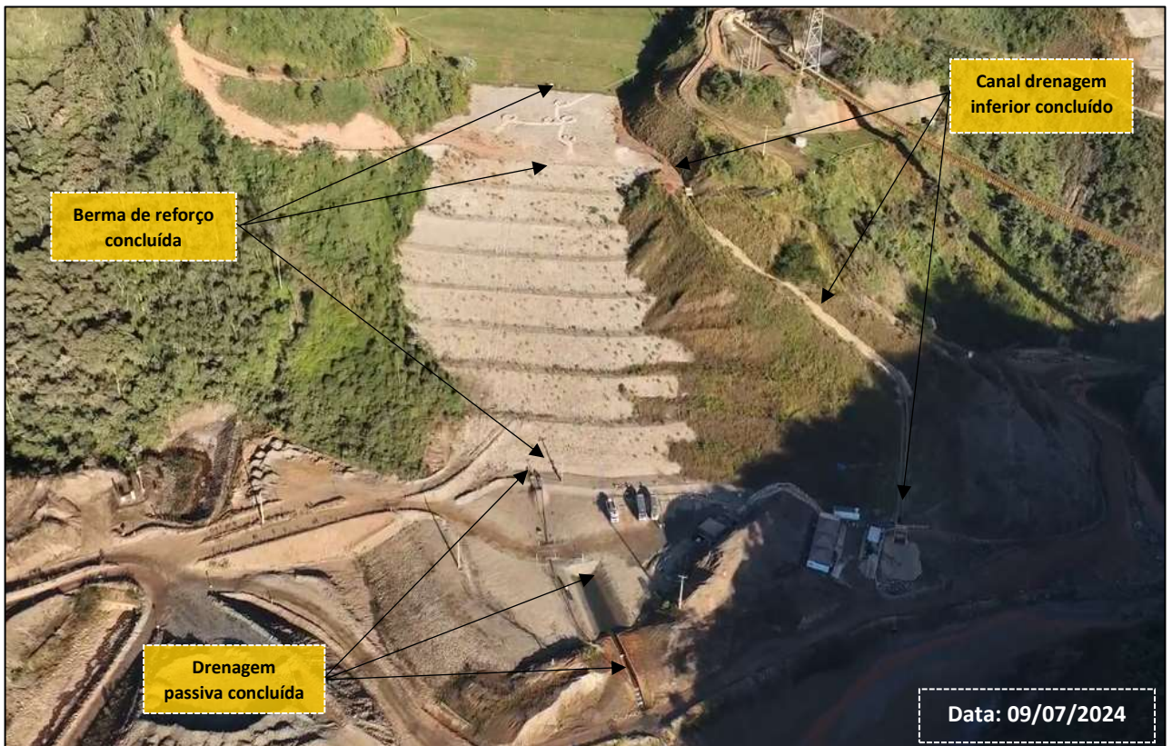
Figura 52: Berma de Reforço e Retaludamento do Barramento Principal – Etapas Concluídas
