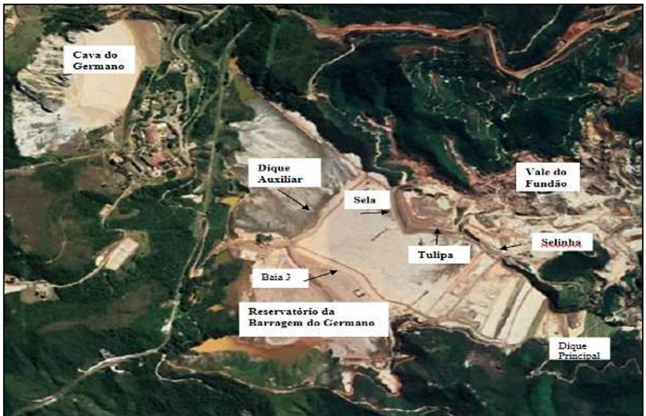
Figura 65: Vista Geral das Barragens da Samarco
