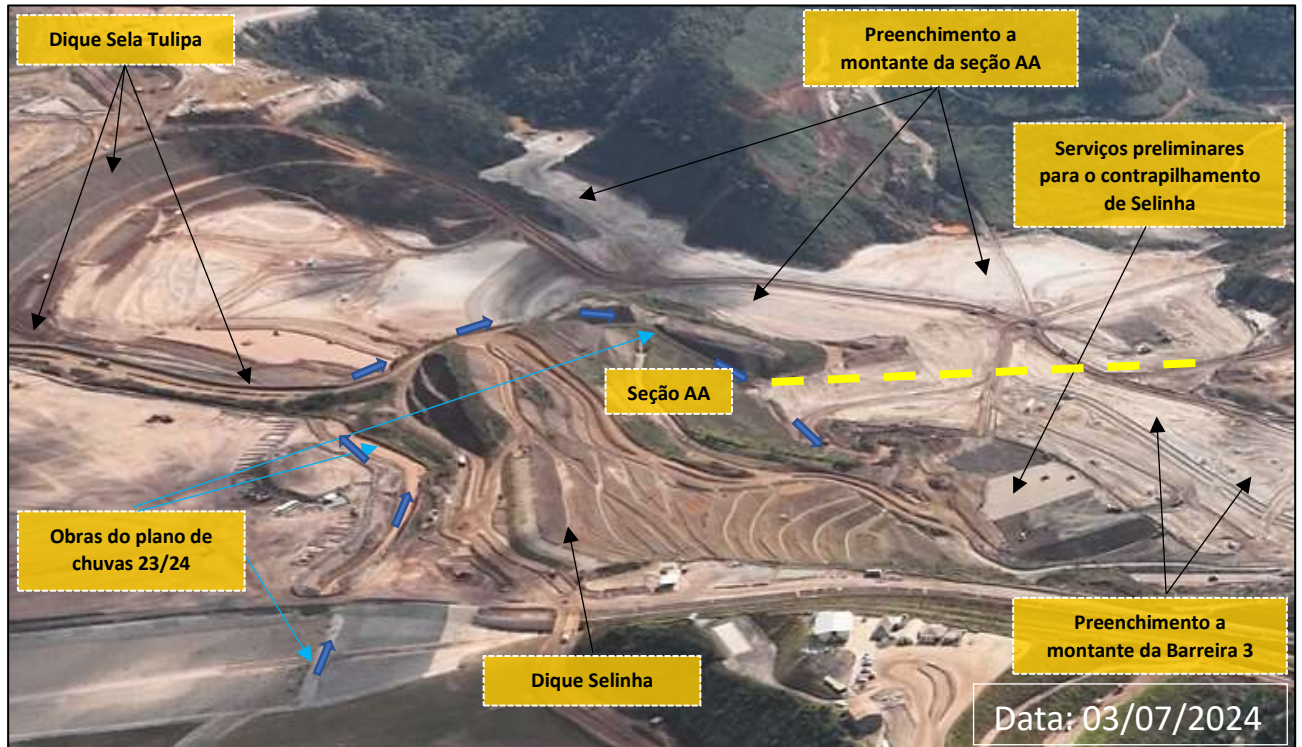
Foto 9: Visão Geral da Região de Sela Tulipa, Selinha e Vale do Fundão (Obras em Andamento)
