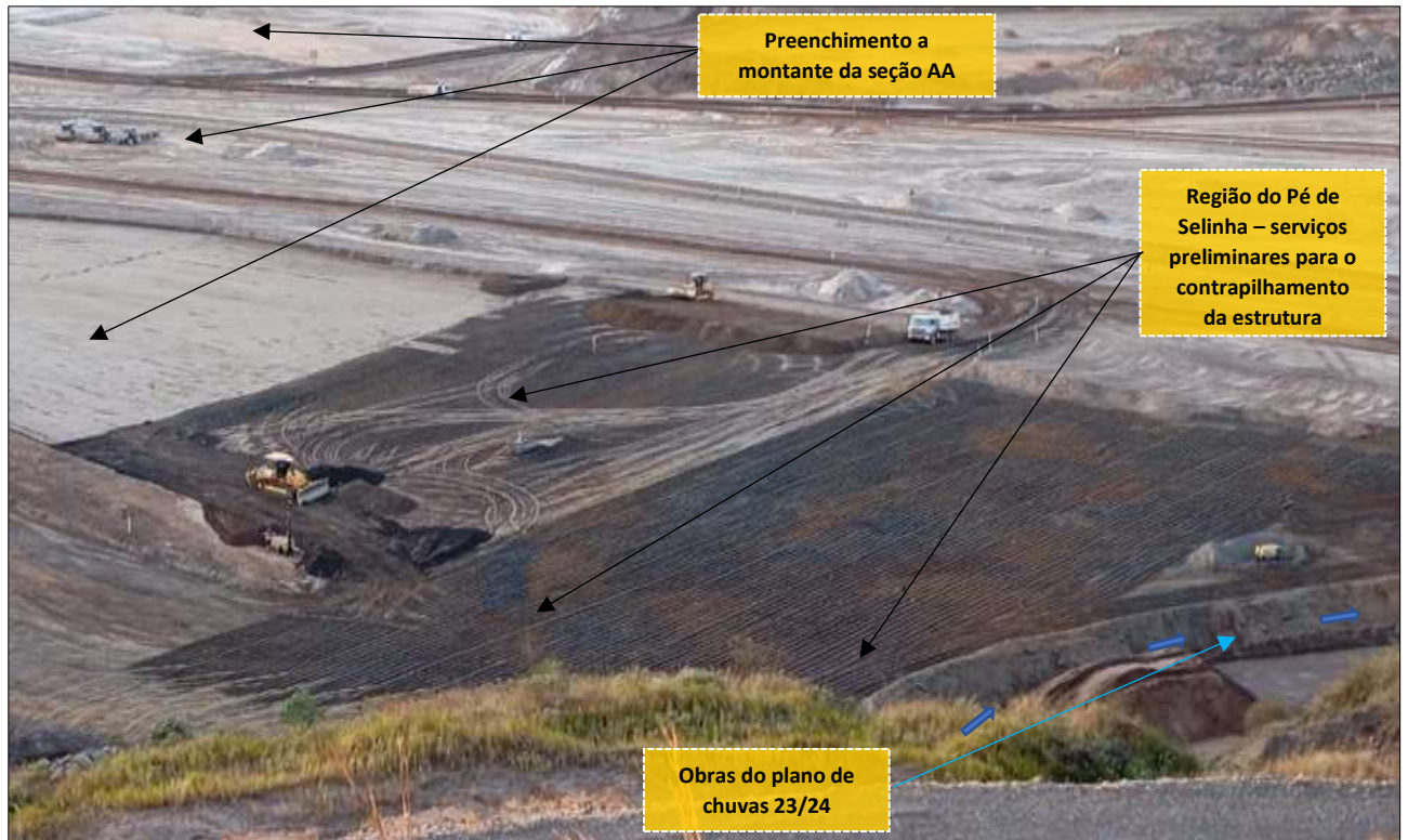
Foto 17: Preenchimento a Montante da Seção AA e Serviços Preliminares no Pé de Selinha (Obras em Andamento)
