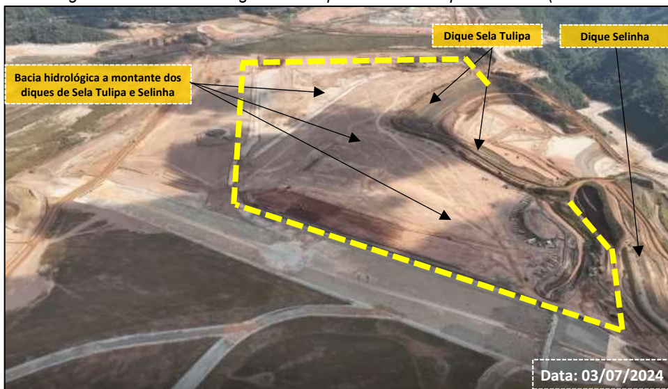
Figura 160: Regrade da Bacia Hidrológica dos Diques de Sela Tulipa e Selinha (Obras em Andamento)
