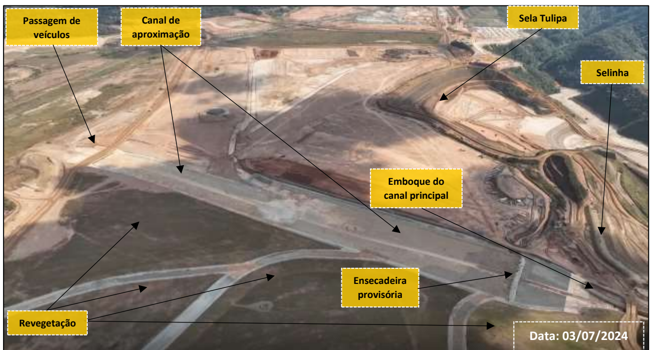
Figura 13: Esboço do Canal de Drenagem Principal (CDP) e Canal de Aproximação – Obras Concluídas
