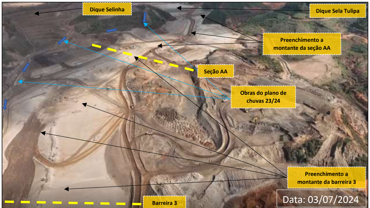
Foto 8: Vista das Obras do Vale do Fundão a Montante da Barreira 3 e Seção AA em Andamento
