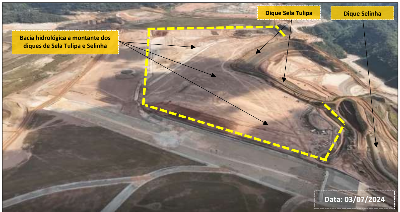
Figura 184: Regrade da Bacia Hidrológica dos Diques de Selinha e Sela Tulipa (Obras em Andamento)
