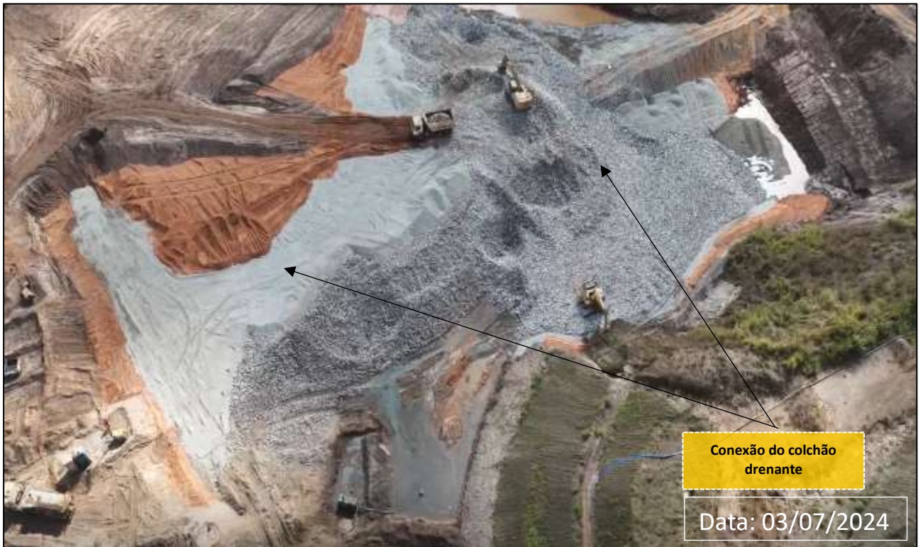
Foto 22: Conexão e Proteção do Colchão Drenante (Obras em Andamento)
