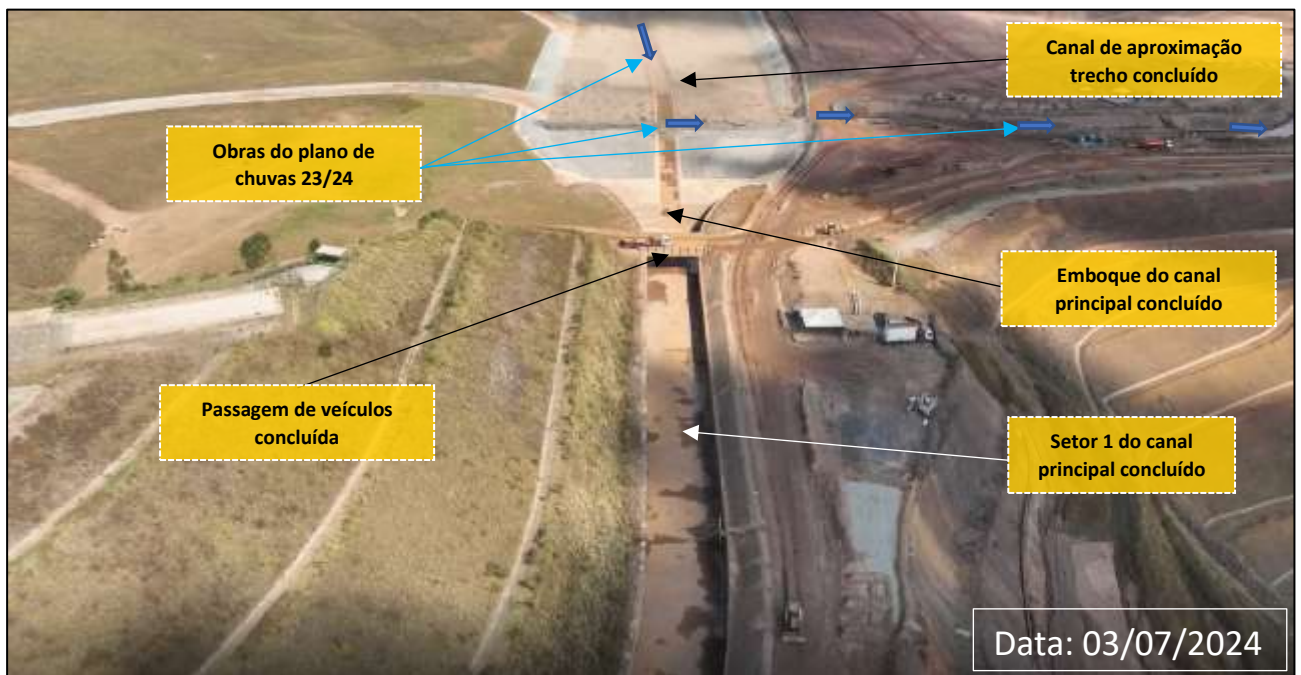
Foto 1: Emboque e Setor 1 do Canal Principal (Obras Concluídas)
