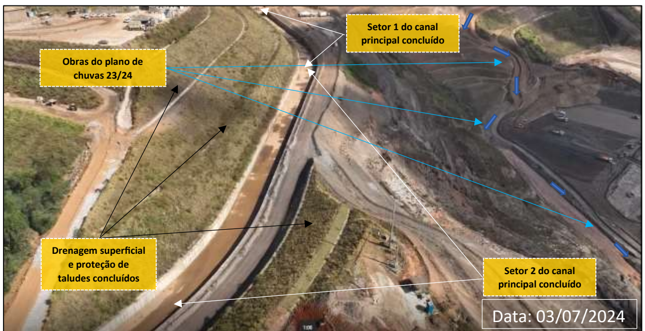
Foto 2: Vista dos Setores 1 e 2 do Canal Principal (Obras Concluídas)
