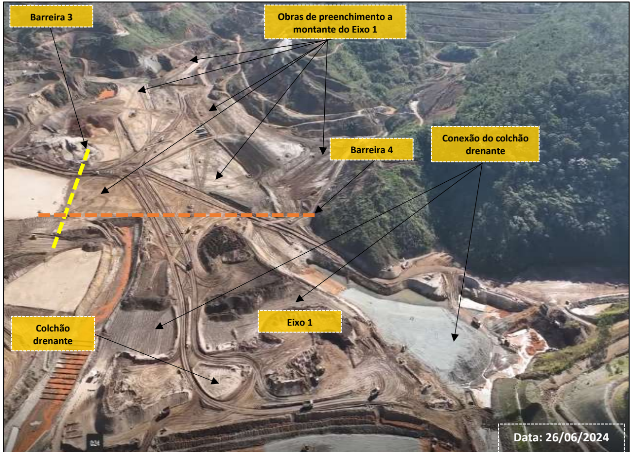
Figura 206: Montante do Eixo 1 (Obras em Andamento)
