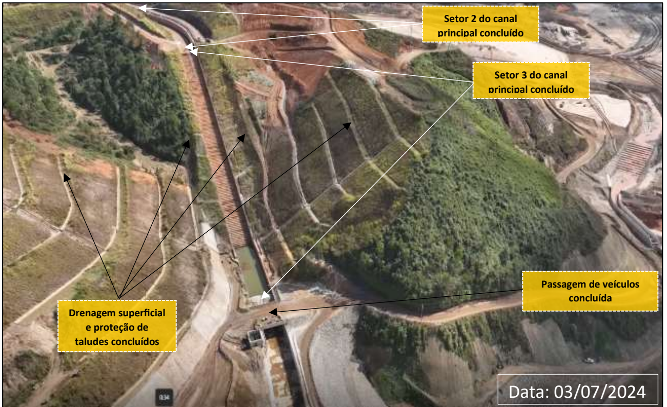
Foto 3: Vista do Setor 2 e 3 do Canal Principal e Travessia de Veículos (Obras Concluídas)
