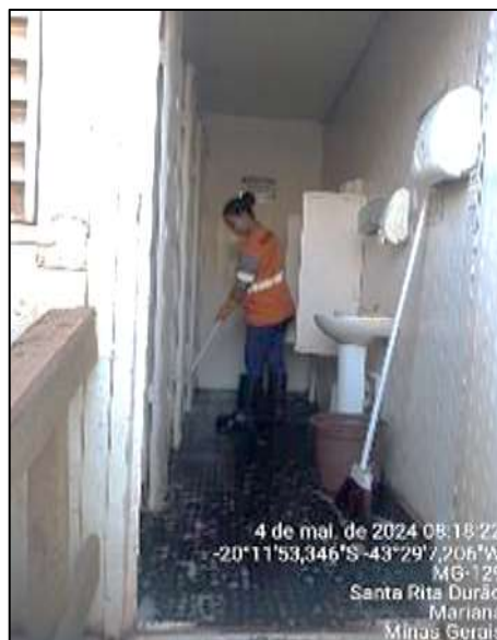
Figura 22: Limpeza e Sucção dos Banheiros Hidráulicos nas Frentes de Serviços – Barragem do Germano
