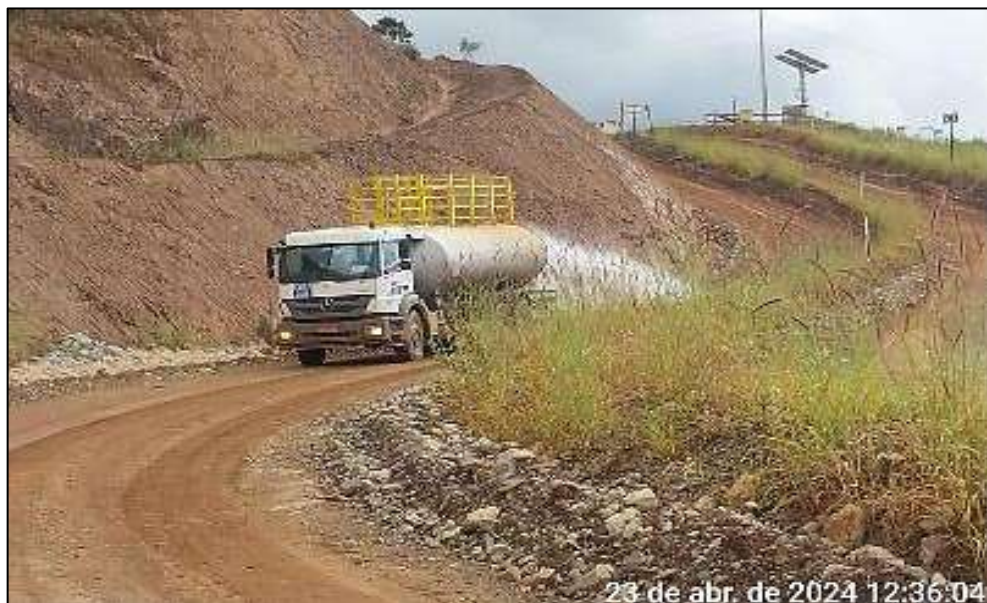
Figura 144: Umectação de Vias na Região da Barragem do Germano
