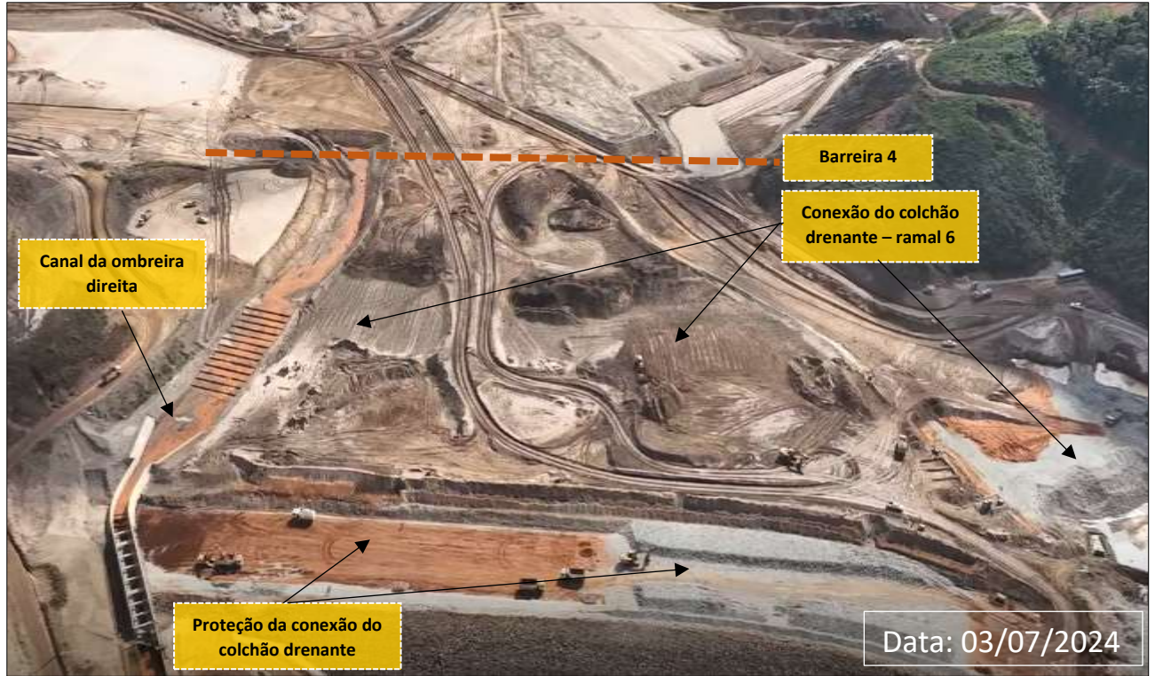
Foto 24: Conexão e Proteção do Colchão Drenante (Obras em Andamento)
