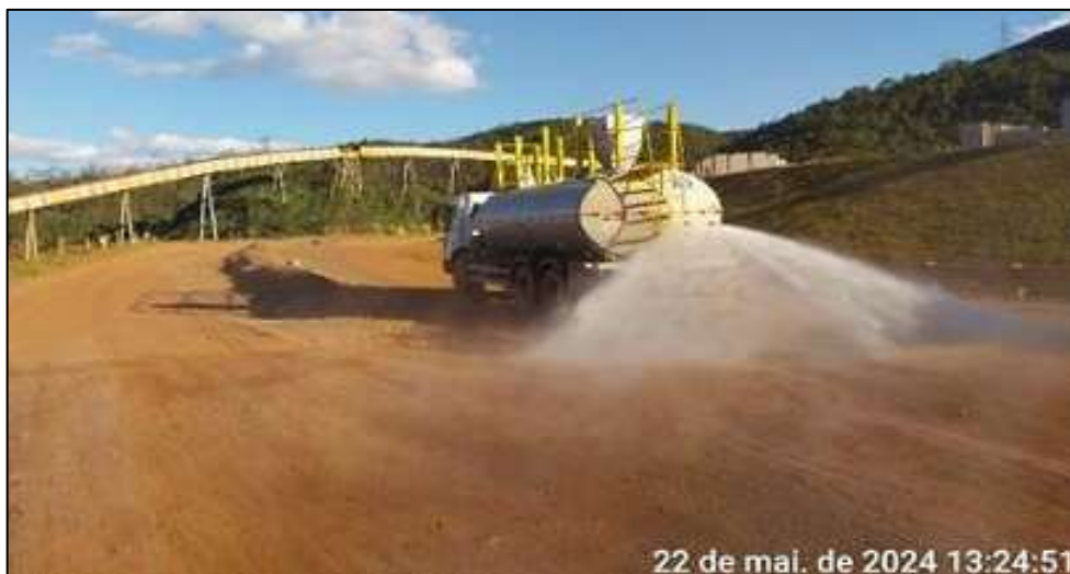
Figura 147: Umectação de Vias na Região da Barragem do Germano
