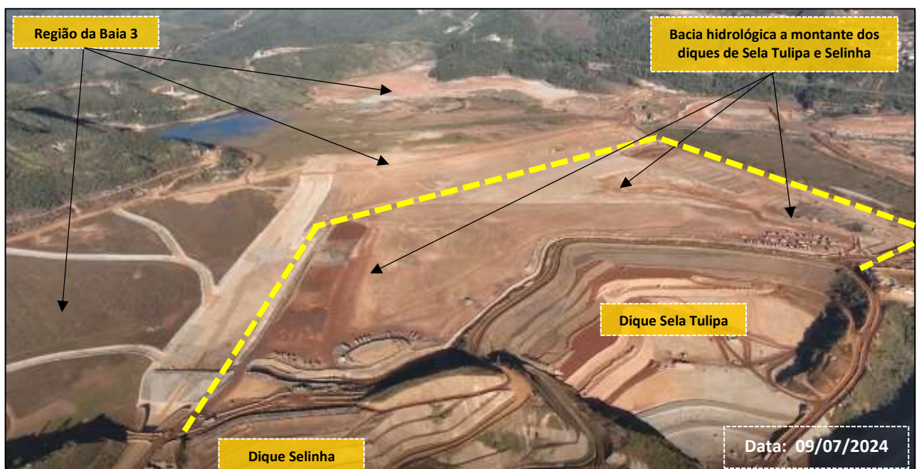
Figura 55: Visão do Regrade da Bacia Hidrológica dos Diques Sela Tulipa e Selinha e Baía 3 (Obras Em Andamento)
