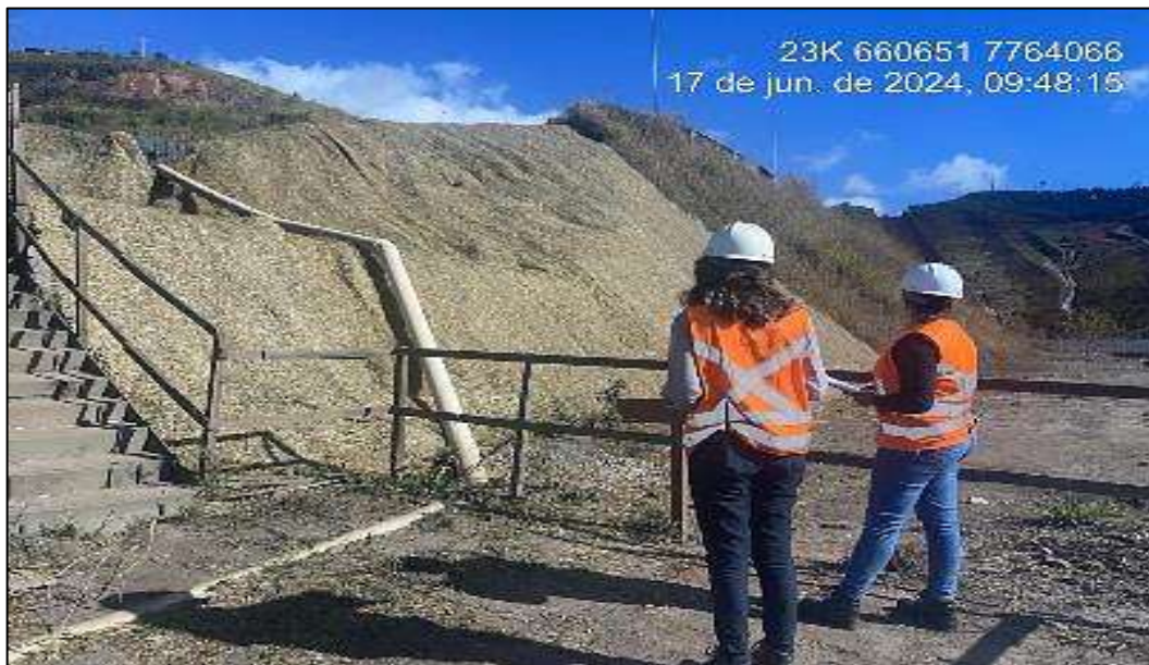
Figura 136: Avaliação dos Taludes do Canal de Drenagem Principal
