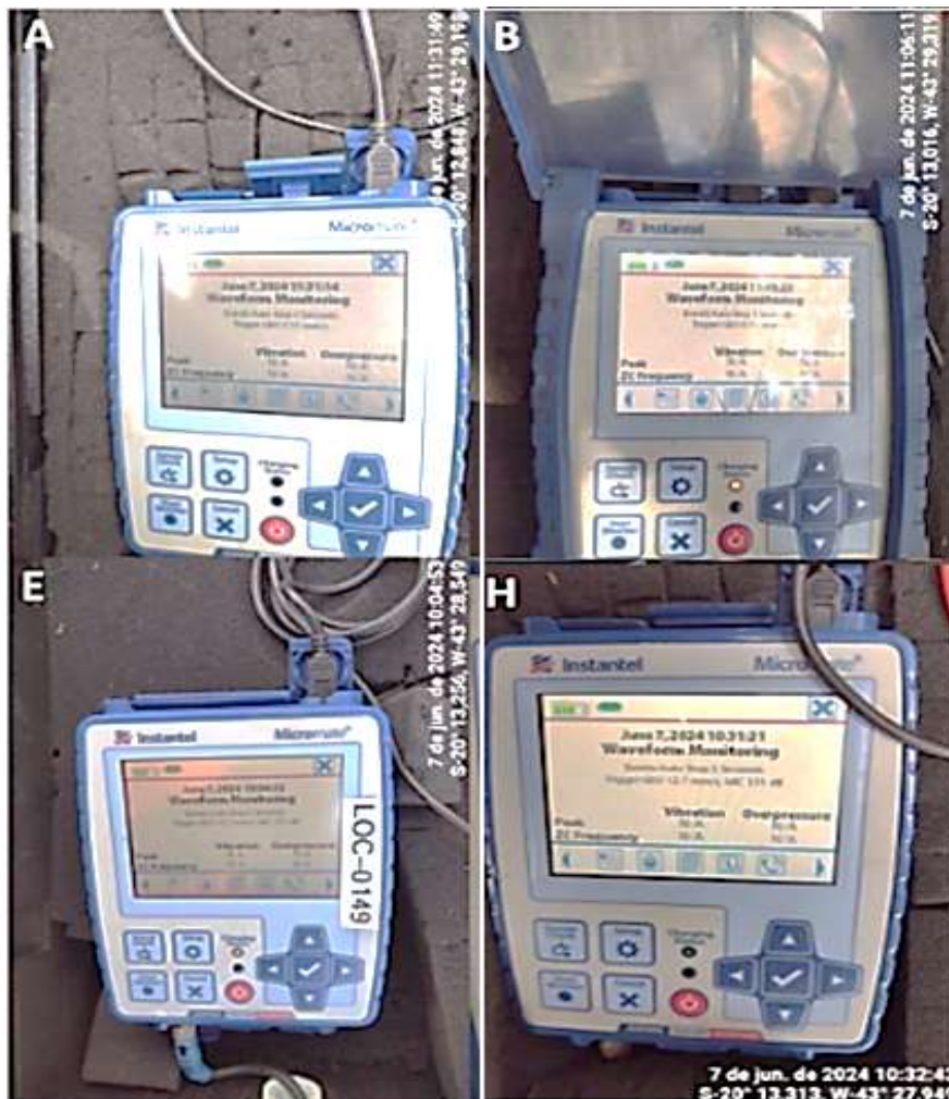
Figura 124: Vistorias de Equipamentos Instalados – Cavidades BG-01, BG-05, LOC-0149 e SM-121
