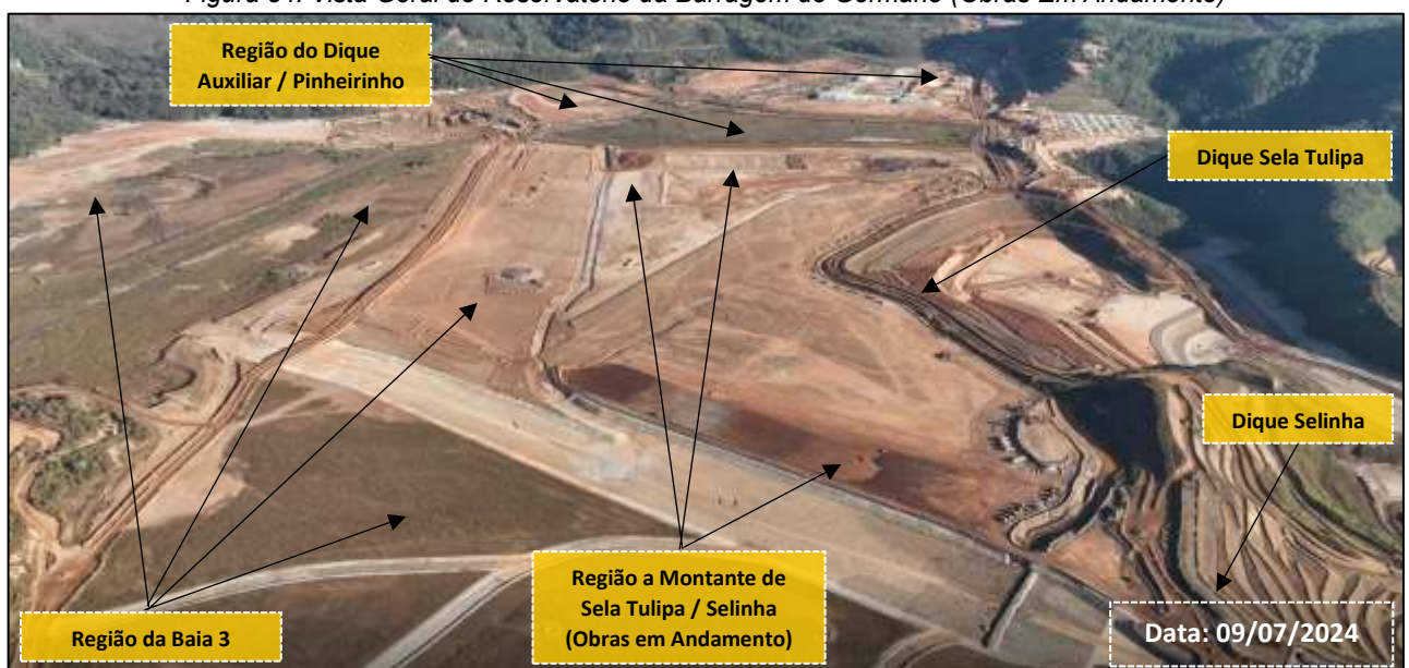
Figura 54: Vista Geral do Reservatório da Barragem do Germano (Obras Em Andamento)
