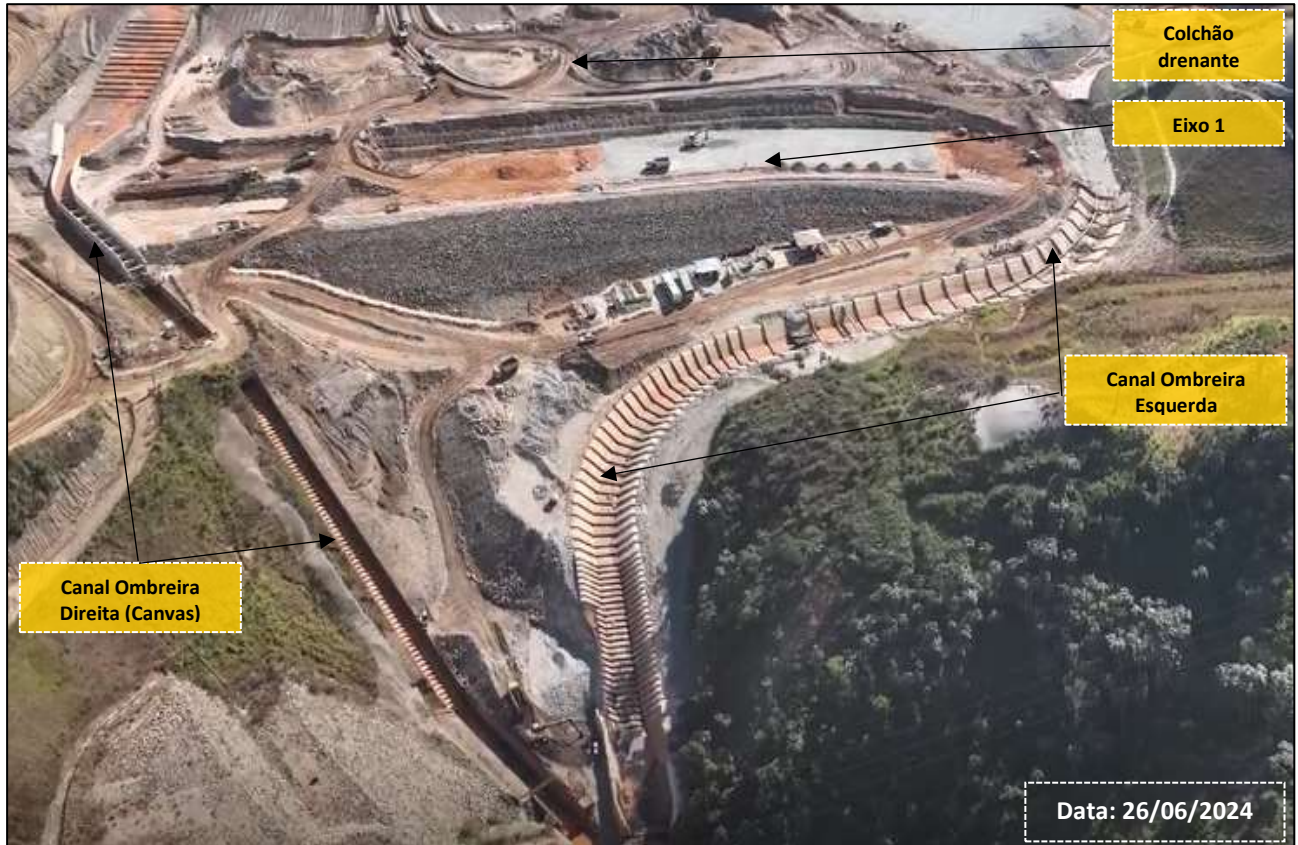
Figura 205: Eixo 1 (Obras em Andamento)
