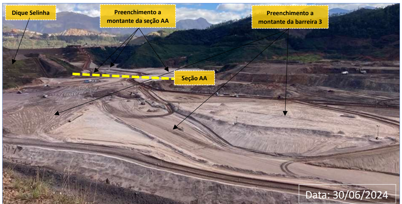
Foto 18: Preenchimentos a Montante da Barreira 3 (Obras em Andamento)
