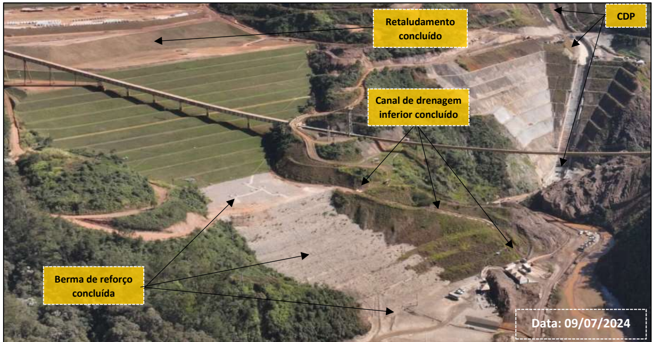
Figura 9: Berma de Reforço e Retaludamento do Barramento Principal – Etapas Concluídas
