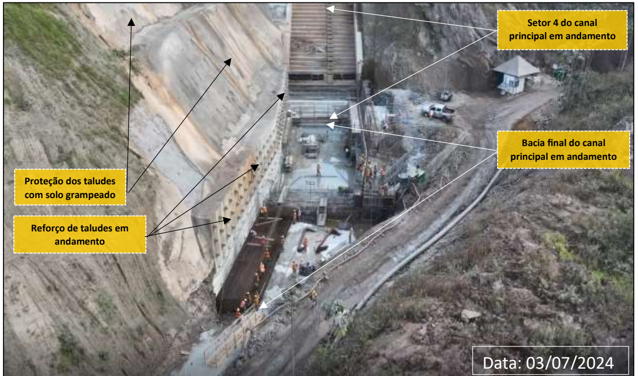
Foto 5: Vista da Bacia Final do Canal Principal (Obras em Andamento)
