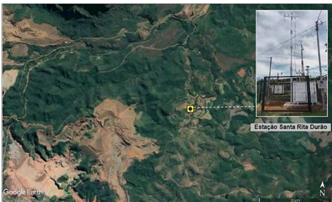
Figura 138: Estação Automática de Monitoramento da Samarco em Santa Rita Durão
