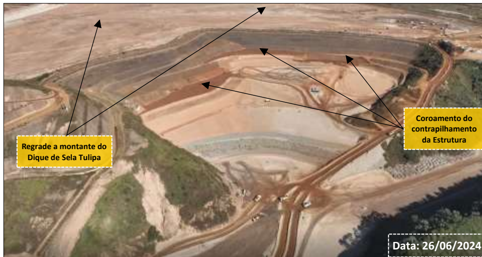
Figura 152: Região de Sela Tulipa – Obras em Andamento
