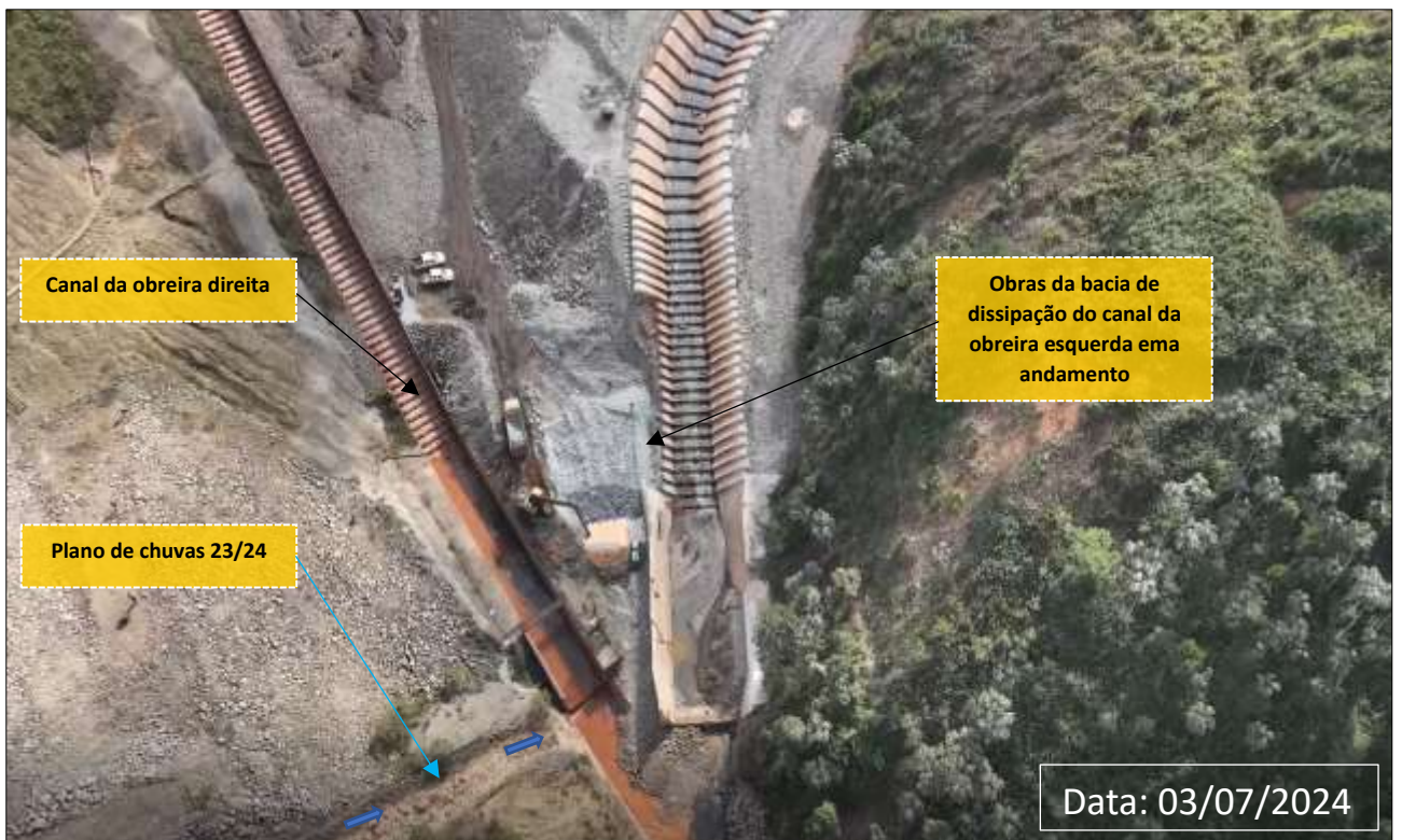
Foto 23: Conexão do Colchão Drenante e Canal da Ombreira Esquerda (Obras em Andamento)
