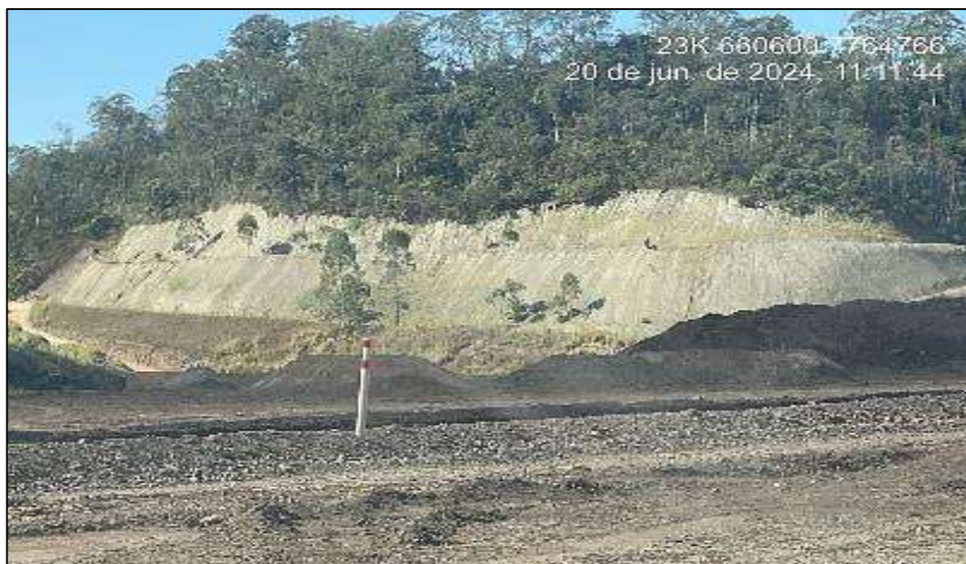
Figura 135: Aplicação de biomanta na Ombreira Esquerda da Barragem Eixo 01
