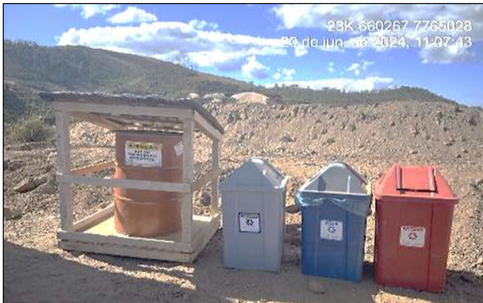
Figura 25: Kit de Emergência Ambiental na Frente de Serviço
