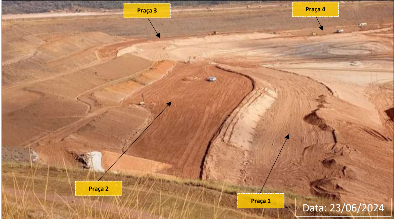
Foto 14: Vista da Execução do Reforço de Sela Tulipa – Praças 1 e 2 (Obras em Andamento)
