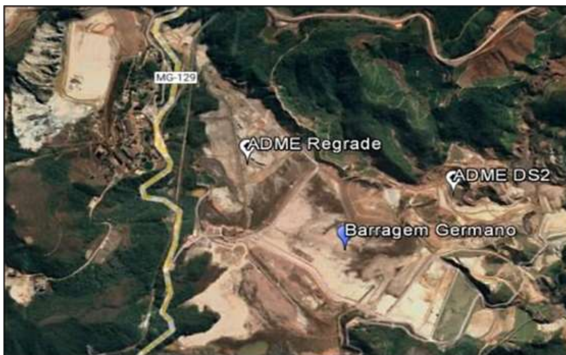
Figura 32: ADMEs das Obras – Barragem do Germano
