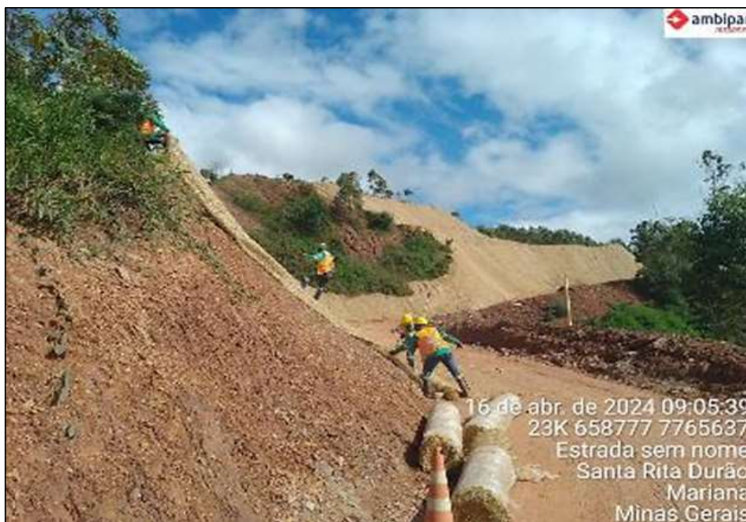
Figura 133: Aplicação de Biomanta no Setor 4 Canal Principal
