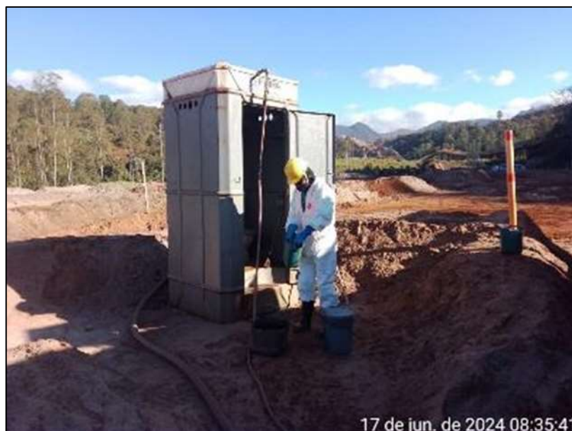
Figura 23: Limpeza e Sucção dos Banheiros Hidráulicos nas Frentes de Serviços – Barragem do Germano
