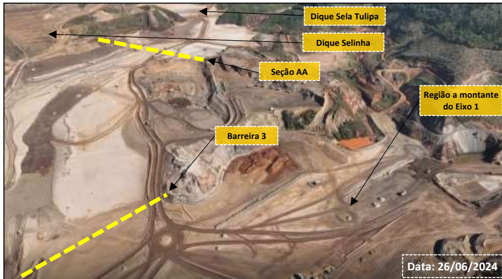
Figura 175: Região a Jusante de Selinha e Sela Tulipa – Obras em Andamento
