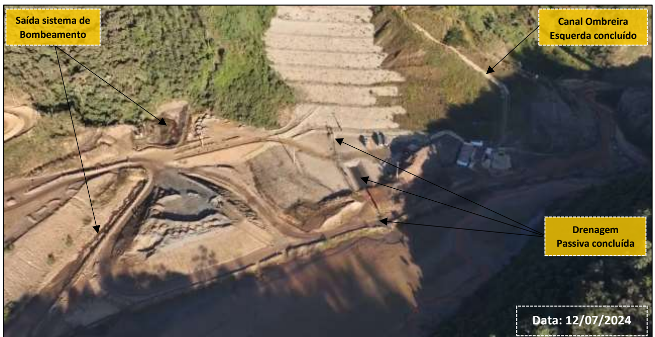
Figura 10: Drenagem Passiva sob a Berma de Reforço – Etapa Concluída
