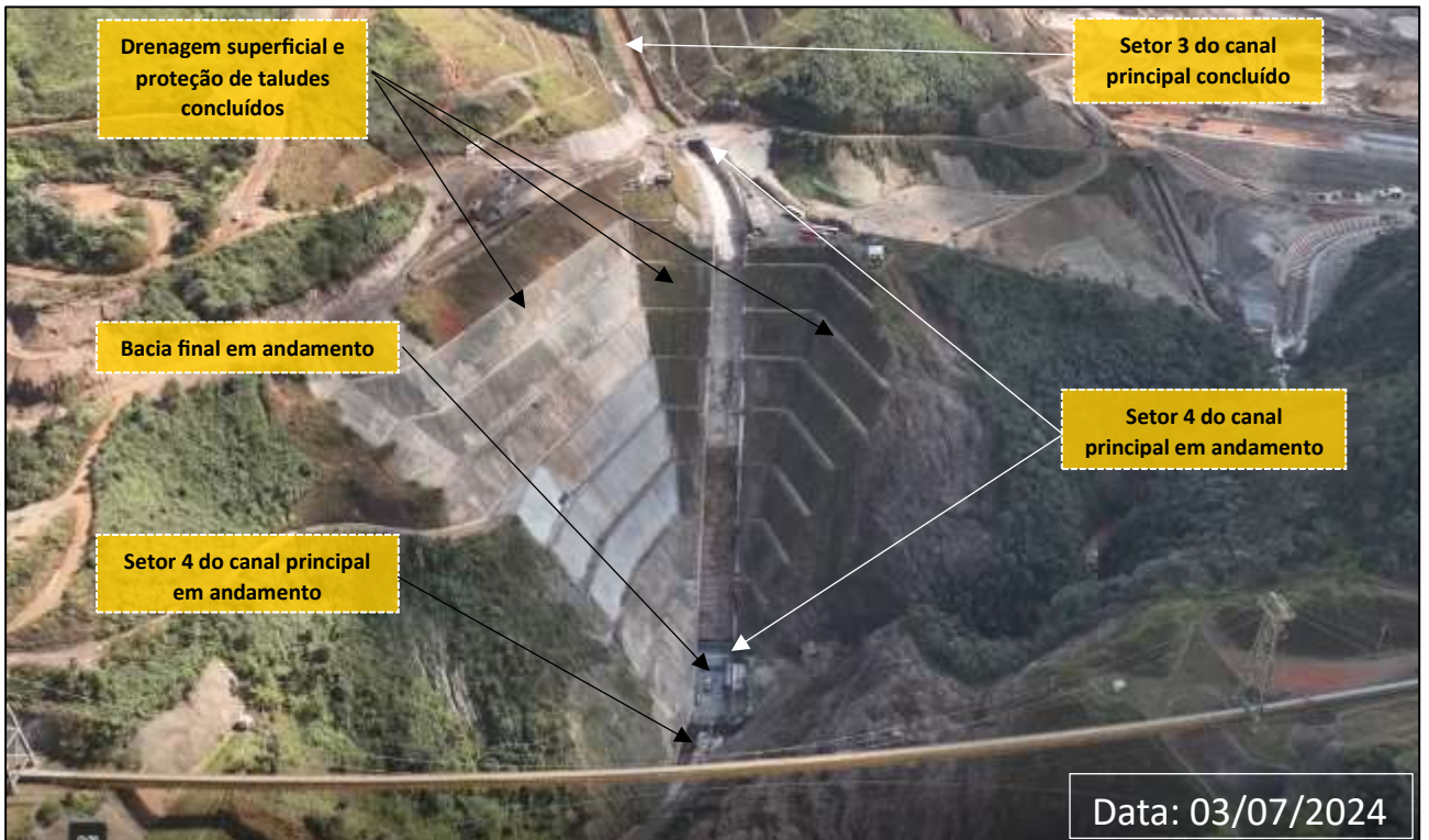
Foto 4: Vista do Setor 3 e 4 do Canal Principal (Obras em Andamento)
